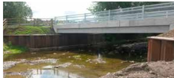
Droichead nua Cl réise aonair 14 méadair i Lios Moling.
