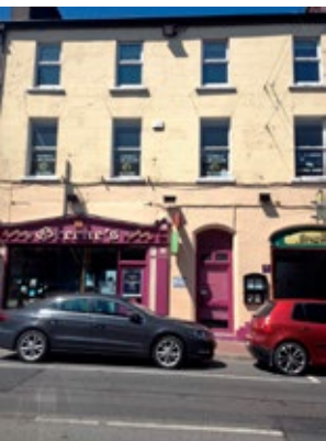
Roimh na hoibreacha
