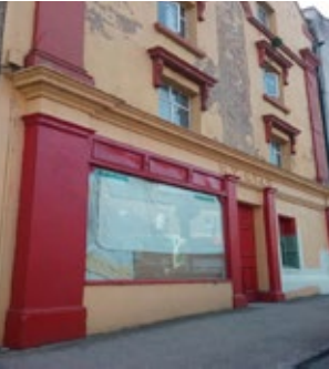
Roimh na hoibreacha
