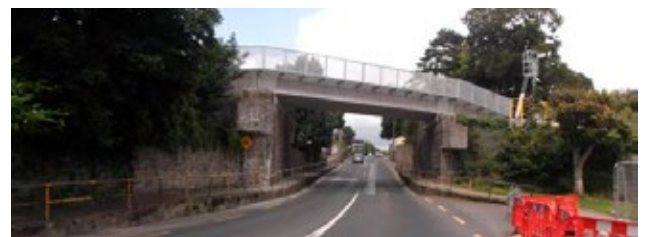
An droichead iarnróid ar an N24 Bóthar an Phoill, Carraig na Siúire tar éis gur críochnaíodh na hoibreacha
